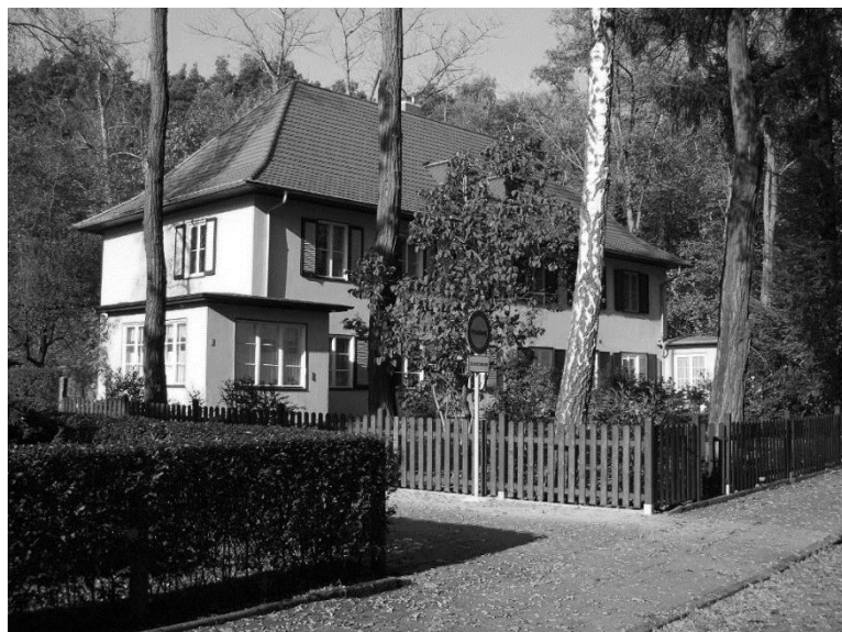
Haus Nr. 4 Mozartstr. in Premnitz, ehem. Direktorenvilla der Köln-Rottweil AG
