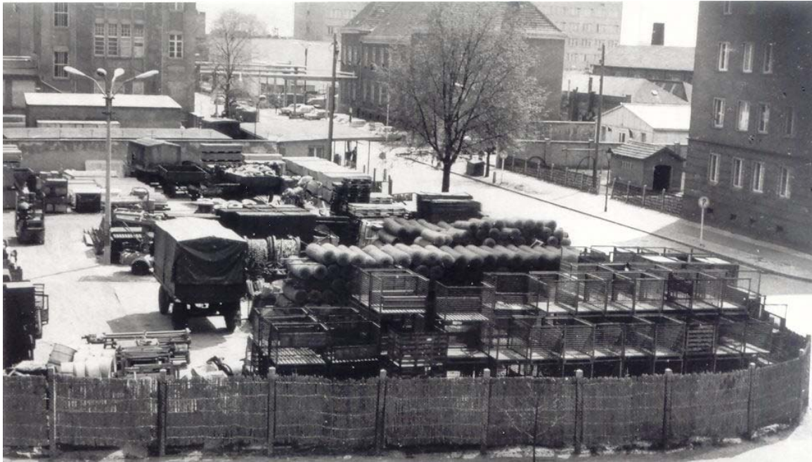
Materialplatz der VRD in der Freienwalder Straße, Ecke Große-Leege-Straße. Im Hintergrund Einfahrt zum Sperrgebiet mit Posthäuschen (April 1976). Quelle: BStU.
