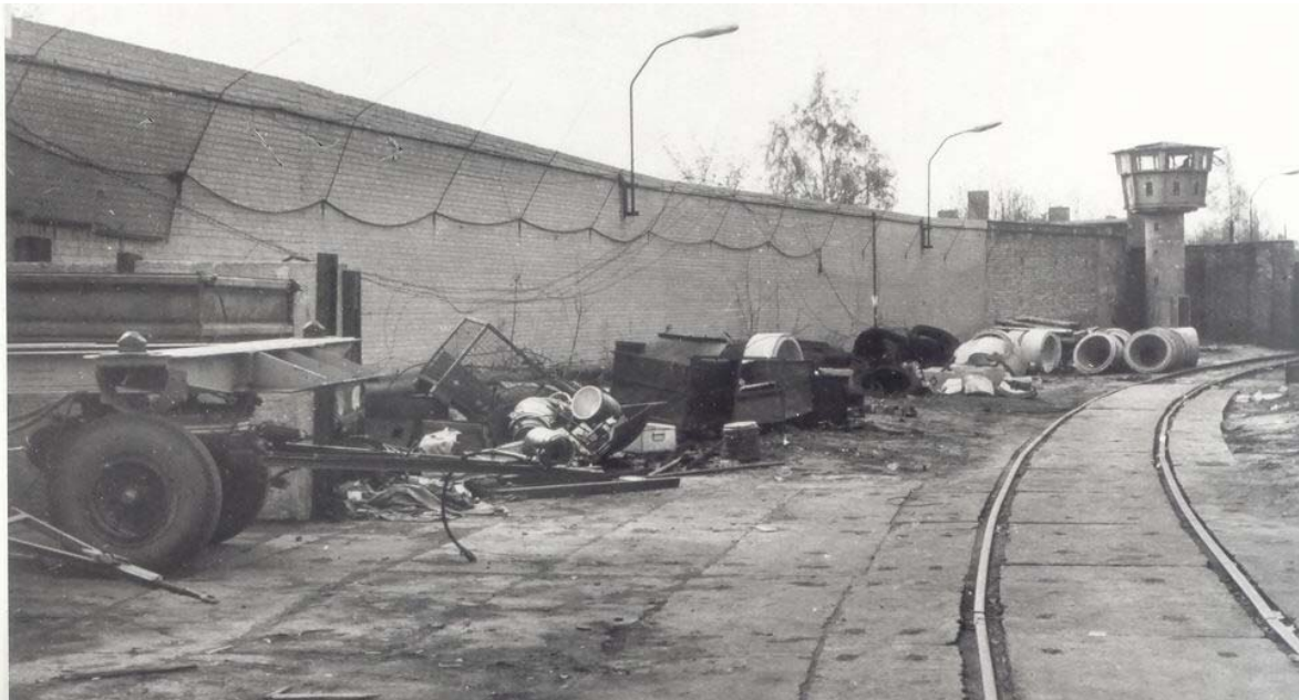
Stichgleis der Industriebahn im Sperrgebiet (April 1976). Quelle: BStU.
